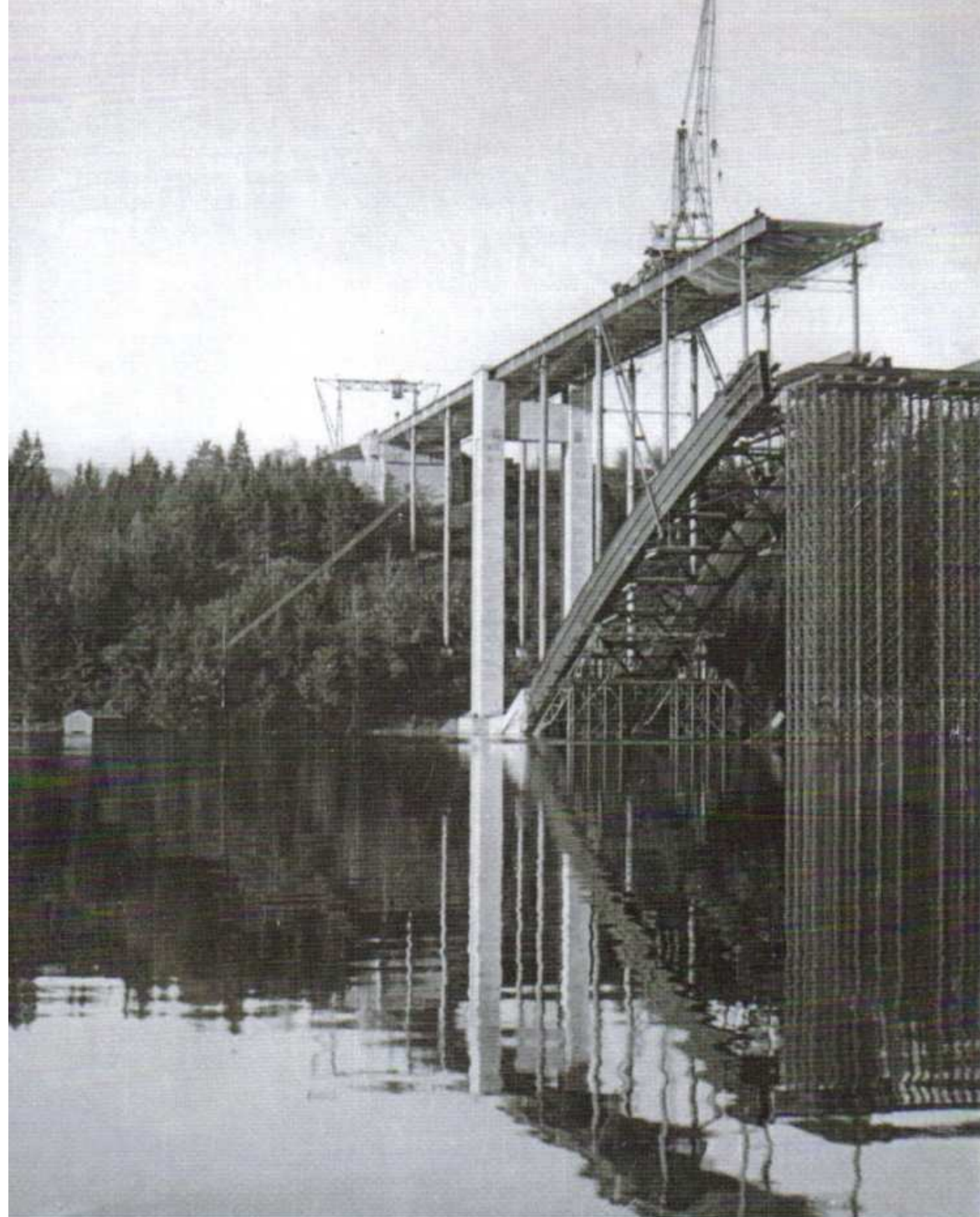
▲ Montáž oblouku před dosažením vojenských věží C
